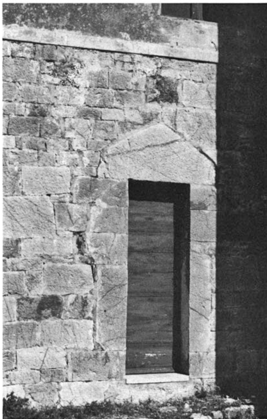
Fig. 12 - Accesso alla chiesa, lungo il prospetto Sud.
