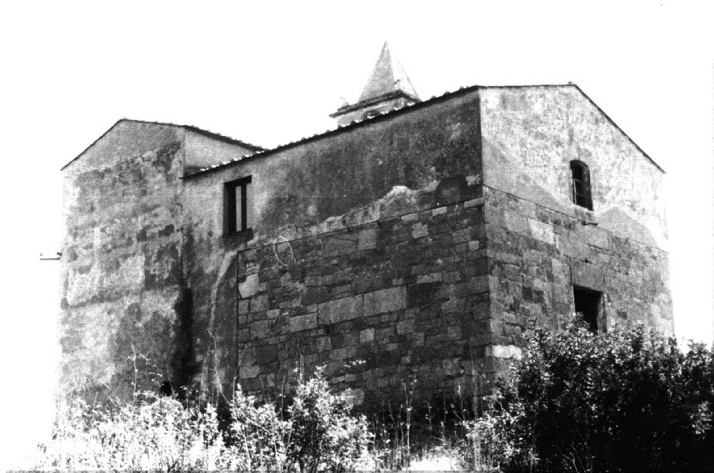
Fig. 28 - Scorcio del santuario da Nord-Ovest. Possiamo notare i conci romanici reimpiegati durante l'ampliamento dell'edificio.
