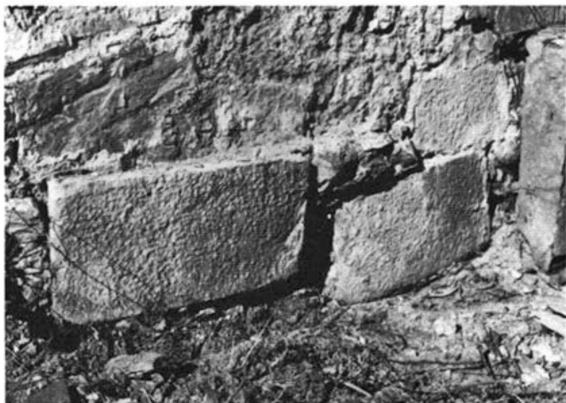
Fig. 10 - Due degli originari conci curvilinei appartenenti all'abside, poi riutilizzati nella muratura del presbiterio.
