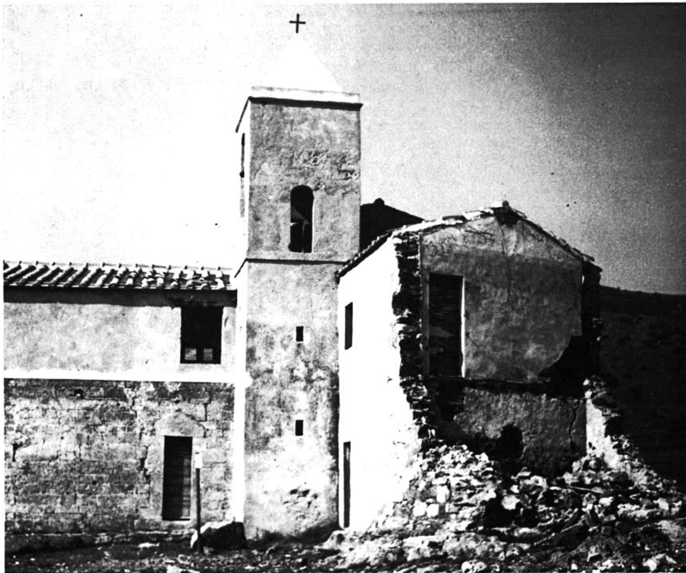
Fig. 51 - Il santuario all'inizio degli anni Cinquanta. Si osservino, sulla destra, le macerie del romitorio, appena demolito. La cuspide del campanile, priva di acroterii, verrà ricostruita dopo la caduta di un fulmine.
